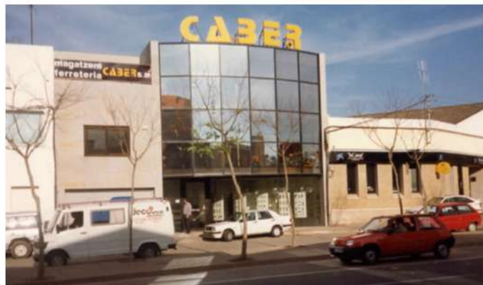
Reforma de les instal·lacions.
