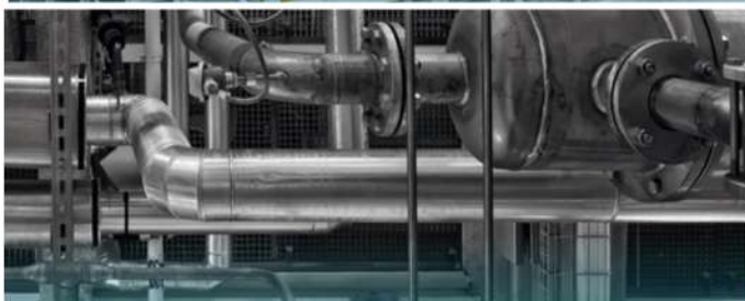
Detalls d'obres realitzades.
