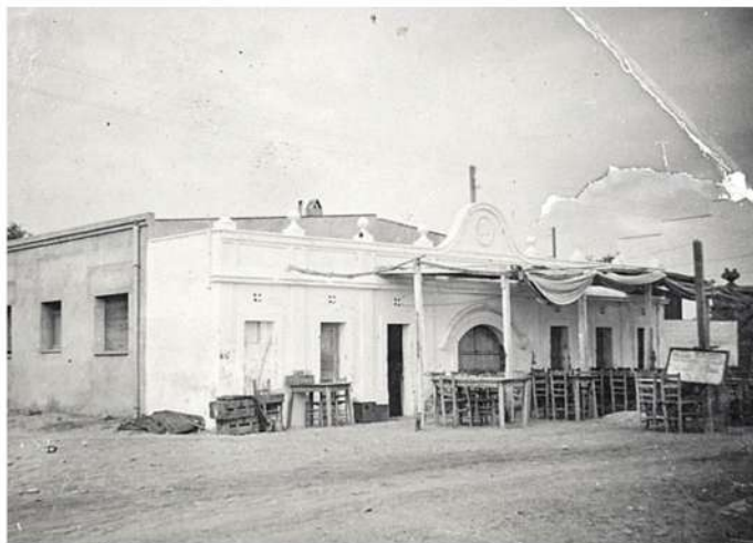
L'edifici i la terrassa de la primitiva construcció.
